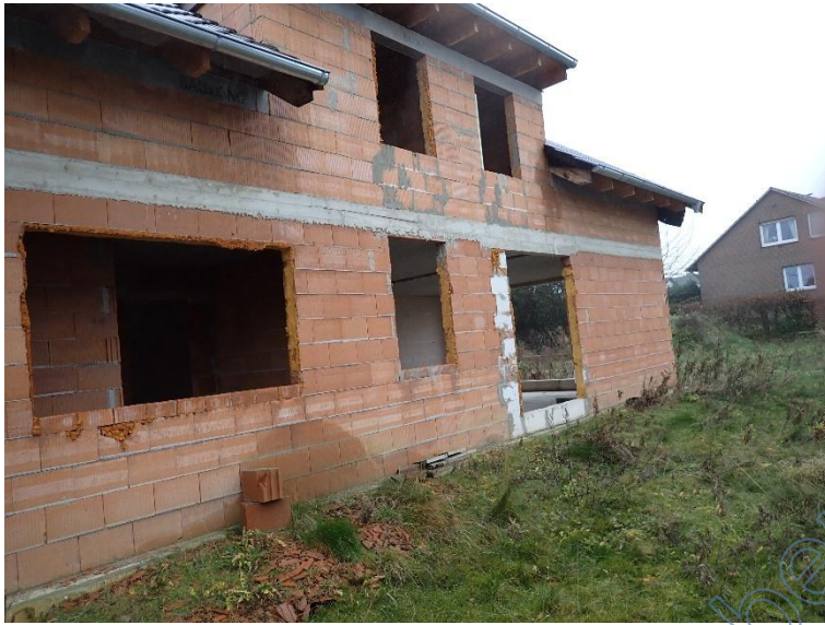
Foto Nr. 7 Seitenansicht
