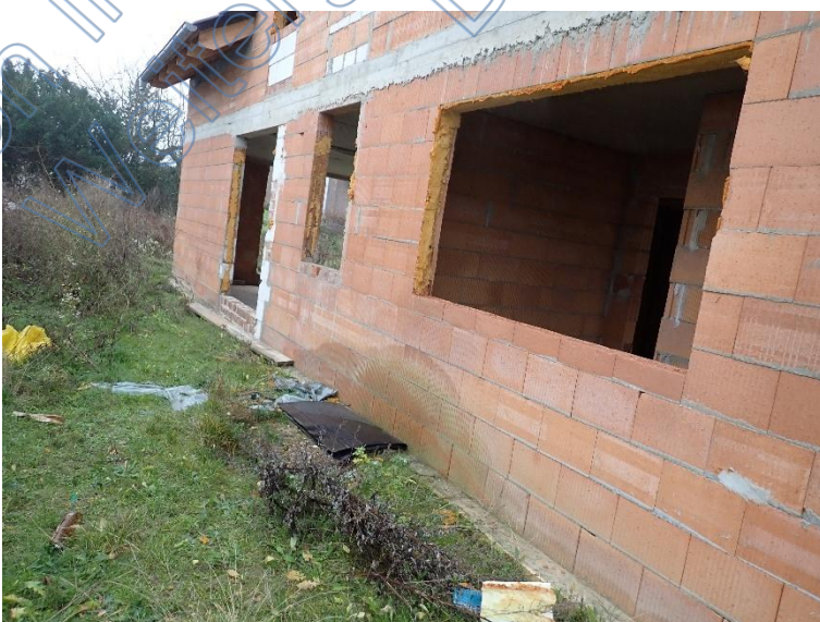
Foto Nr. 3 Seitenansicht
