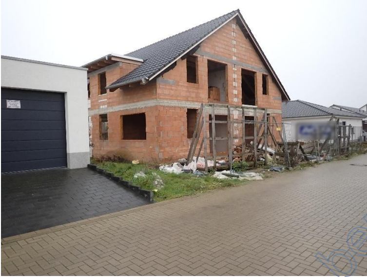
Foto Nr. 1 Straßensicht
