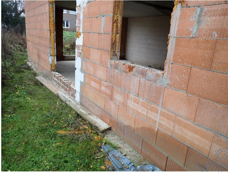
Foto Nr. 4 Seitenansicht
