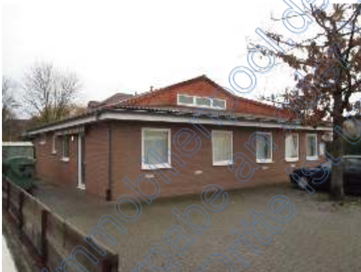
Ansicht von Südosten - TE Nr. 1
