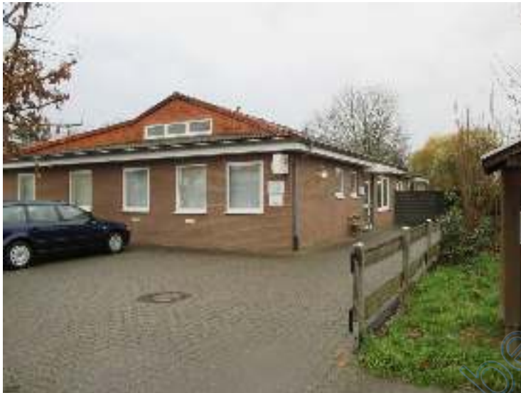
Ansicht von Nordosten - TE Nr. 1
