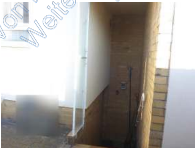
Außentreppe zum KG
