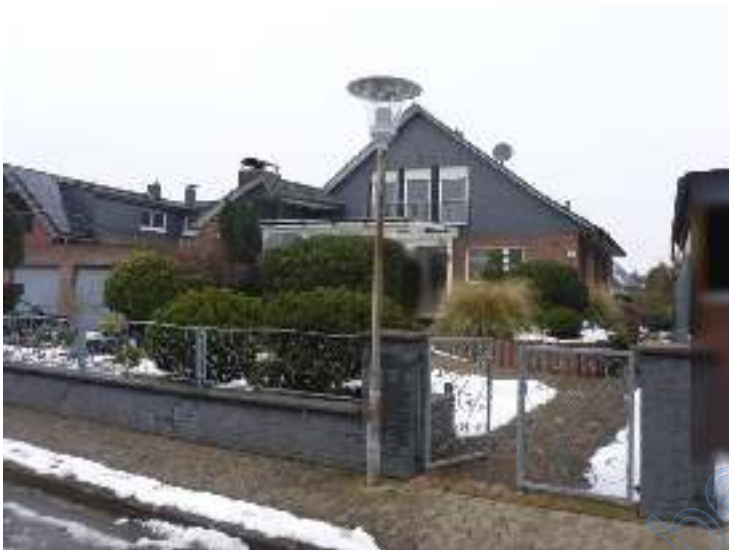
Gebäude 1 - Ansicht von Südosten
