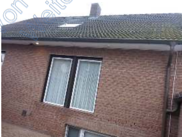
Gebäude 1 - Ansicht von Westen
