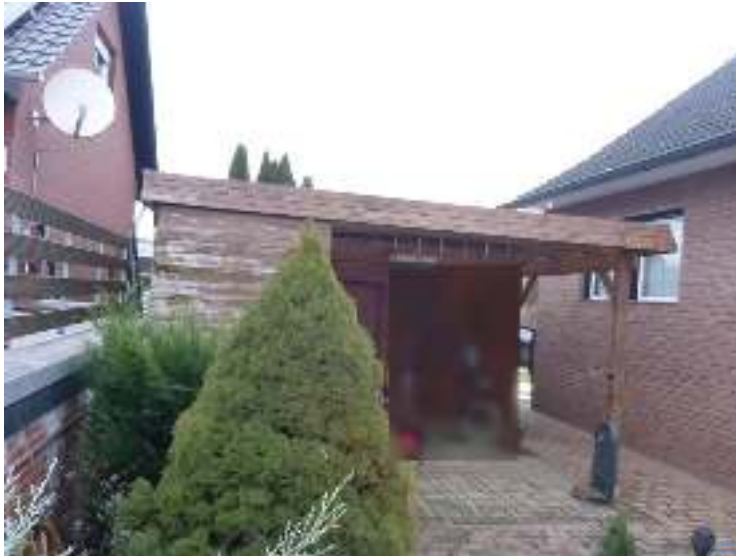
Gebäude 3 / Holzschuppen mit Vordach - Ansicht von Süden
