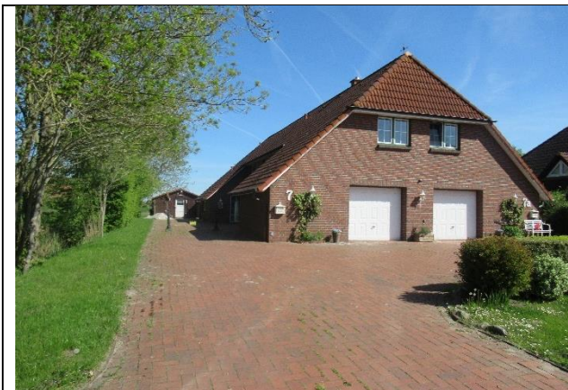
Ansicht von der Straße (Süden)
