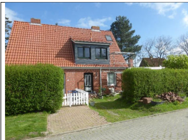
Ansicht von der Straße
