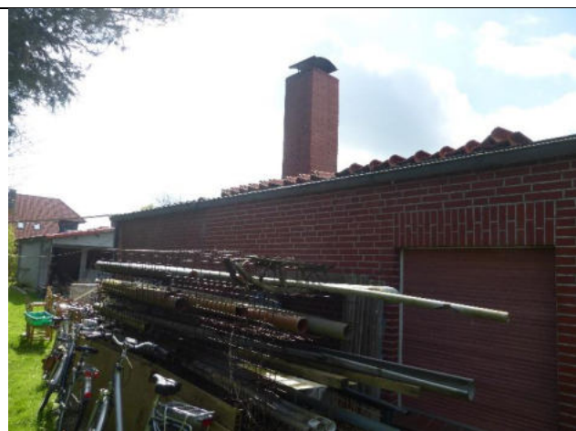
Ansicht (Anbau) von Nordwesten
