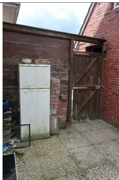
Holztrennwand zwischen Whs und Garage
