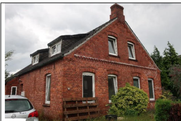
Ansicht westliche Wohnhausseite
