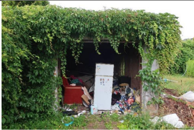
Ansicht von der westlichen Einfahrt
