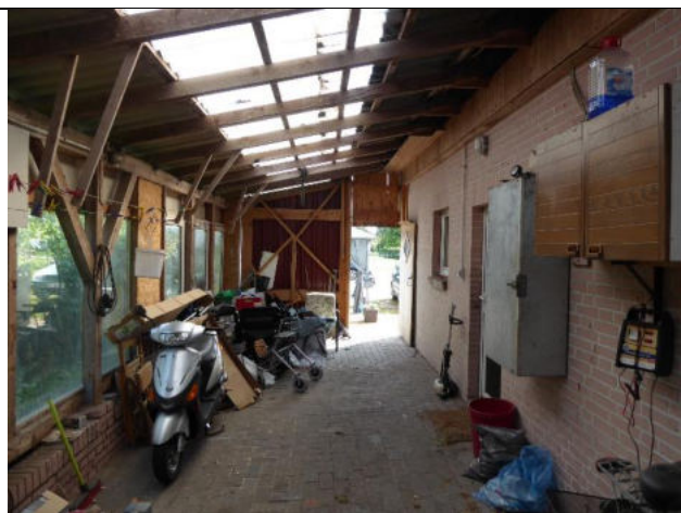
Teilansicht Nordseite (Carport, Eingang Wo. C)
