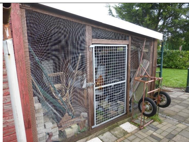
Schuppenanbau an Werkstatt (NW)
