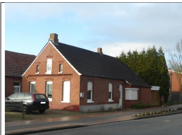
Ansicht von der Straße (SO)
