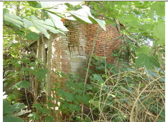
Ansicht Anbau von Norden
