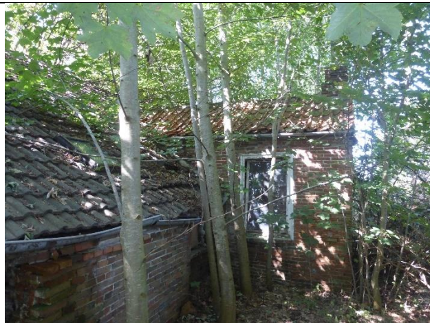
Teilansicht von Nordosten (Anbau)
