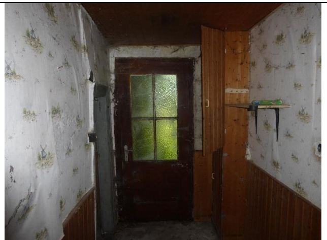
Ansicht Flur (Vorderhaus)
