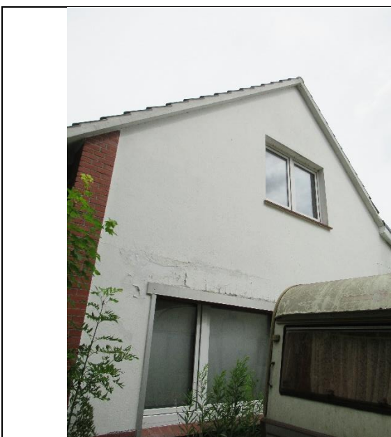
Ansicht Hausfassade südlich
