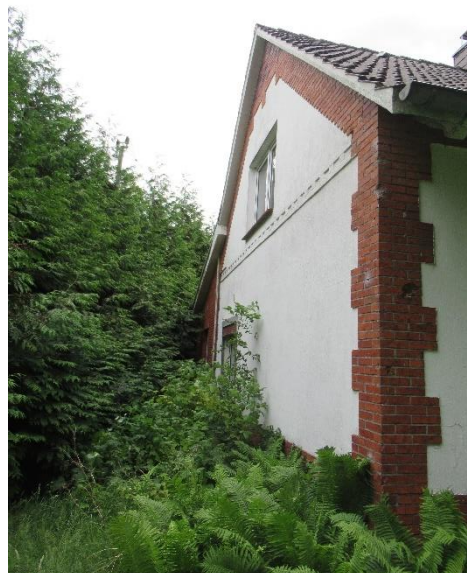
Ansicht Hausfassade nördlich
