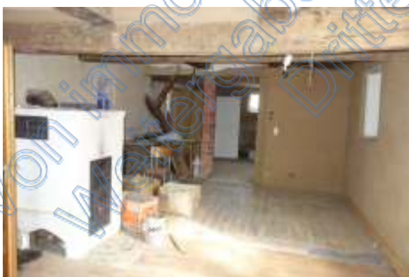
Rückbau Festbrennstoffkamin und Trennwandaufbau( Raum1 zu Raum 2 OG)
