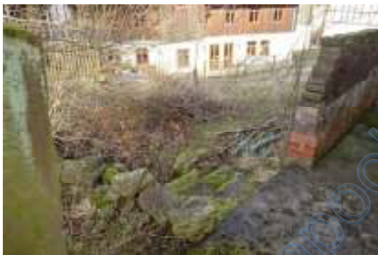
Freitreppen, Rampe, Natursteinberäumung
