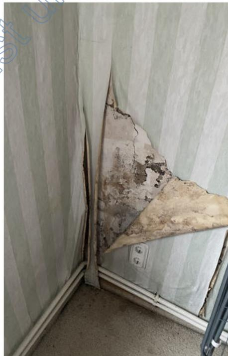
Erdgeschoss: Zimmer im Anbau, Detail Schimmel in Zimmerecke
