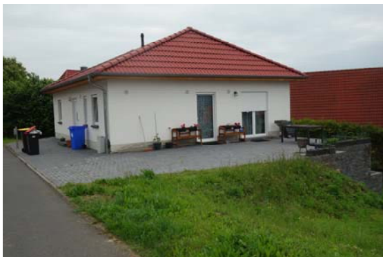
Wohngebäude, straßenseitige Ansicht
