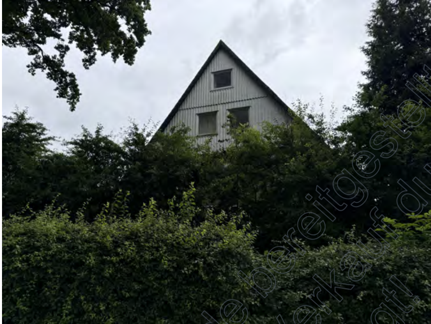
Bild 3: Giebelansicht des Bewertungsobjekts aus westlicher Richtung
