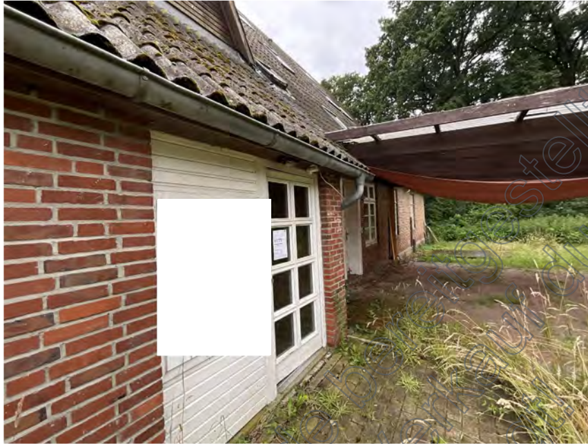
Bild 5: Ansicht des Hauseingangsbereichs des Bewertungsobjekts
