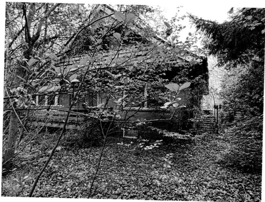
Vorderansicht des Gebäudes 19b
