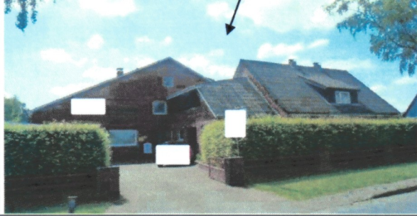
seitliche Ansicht (ursprünglicher Gebäudebereich)
