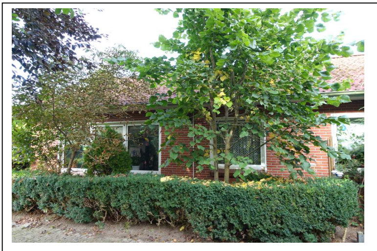
Ansichten der westlichen Gebäudeseite
