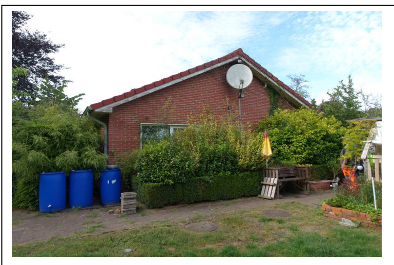
Ansichten der südlichen Gebäudeseite
