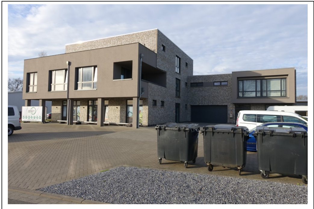
Ansicht aus östlicher Richtung
