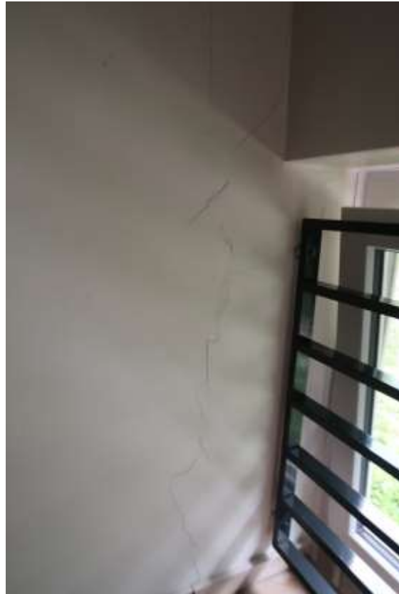
- Wohnungstür der Wohnung C3 im Dachgeschoss und Riss in Treppenhauswand -
