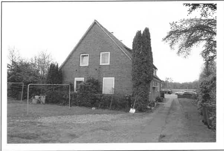
Ansicht aus nördlicher und
