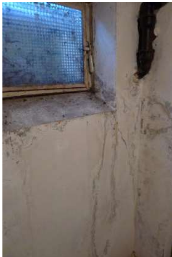
- Gaszentralheizungsanlage und Kellerraum mit Feuchtigkeitsflecken -
