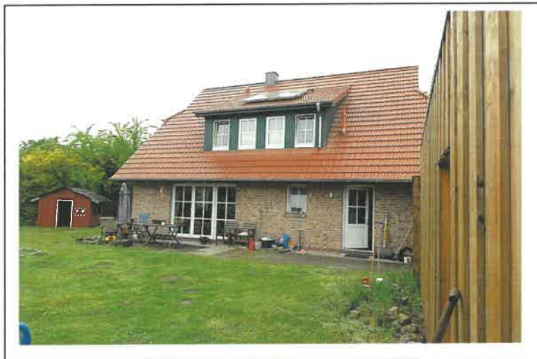
Ansicht des Gebäudes aus östlicher Richtung
