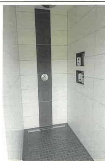
Badezimmer: Das Badezimmer ist gefliest, die Wände ca. 1,80 m hoch.
