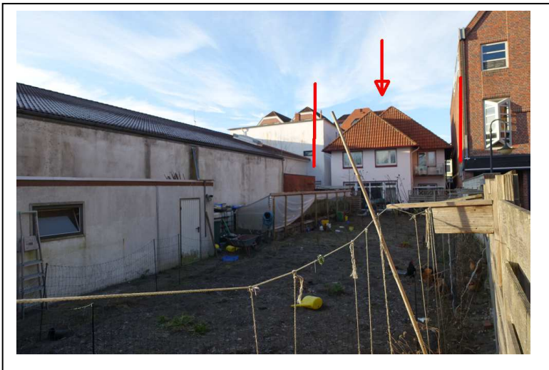
Ansicht des Objektes aus östlicher Richtung
