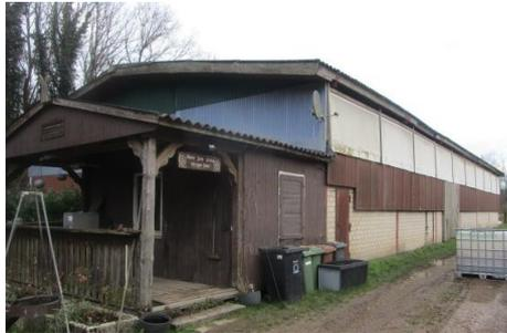
Eingeschossige Stahlhalle mit Mauerwerkssockel als Kalthalle. Einzelfundament und Gründungssohle Stahlbeton als Reitplatz hergerichtet. Tretschicht Sand. Einseitig teiloffener Giebel als Zugang zu der Halle Satteldach mit Eternitplatteneindeckung. Seitenverkleidung Lichtbäder und Eternitplatten, Eingangsseite Trapezbleche. Einfache Elektroausstattung. Dem Halleneingang vorgelagert Aufenthaltsraum (Stübchen) in Holzbauweise mit Holzofenheizung. Baujahr 1996
