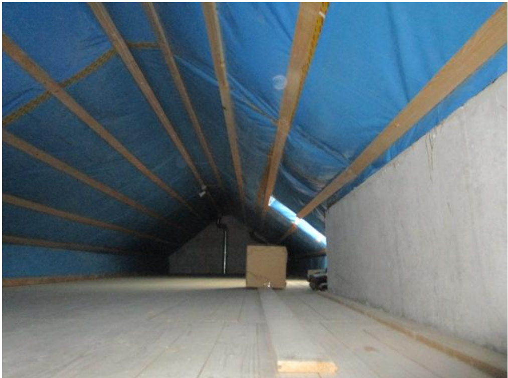
10) Blick in den Spitzboden
