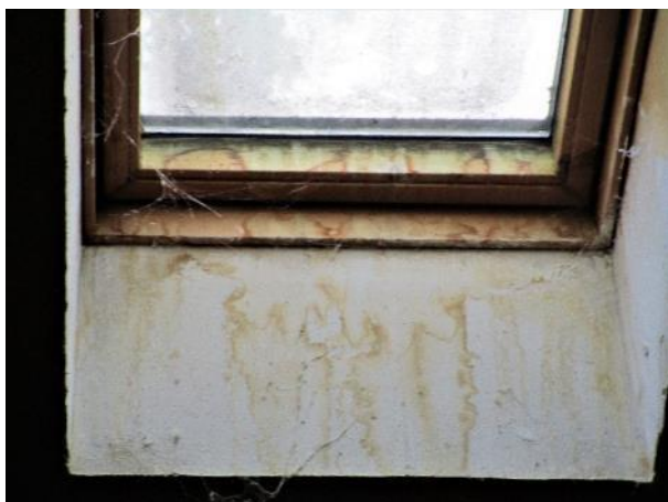
Fenster undicht/abgängig
