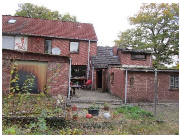
Terrasse mit Überdachung
