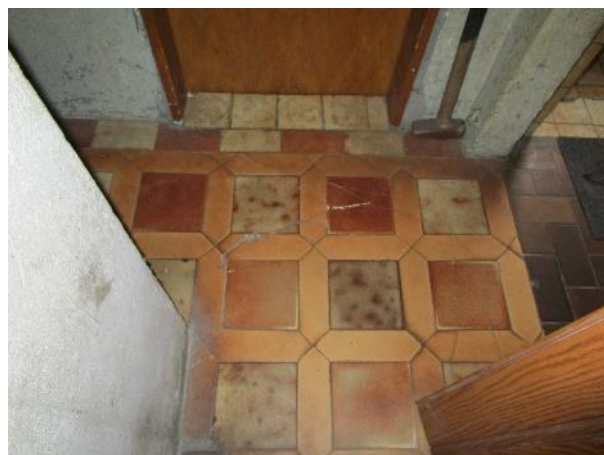
Fußboden abgesackt
