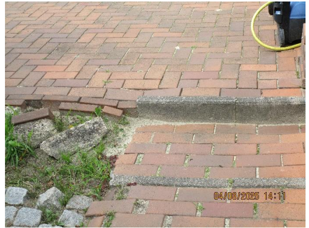
Befestigung abgesackt
