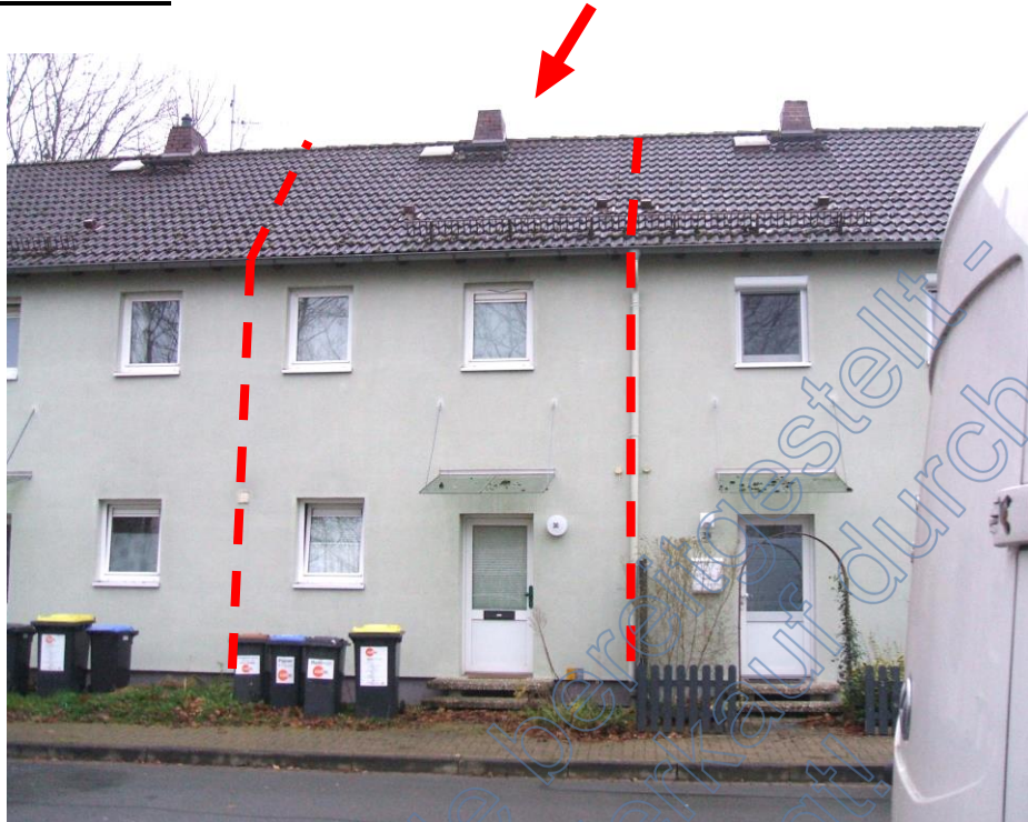
Foto 1: Reihennittelhaus, Nordwestansicht aufgenommen am 29.11.2021
