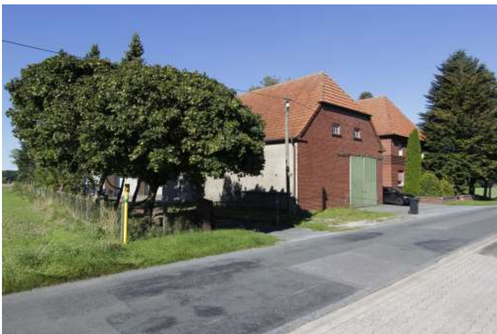
Ansicht Süd-Westen - Scheune
