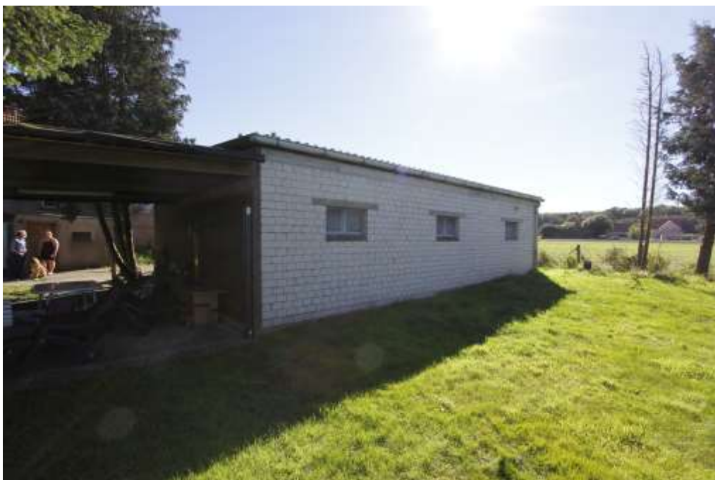
Ansicht Nord-Osten – Garagengebäude
