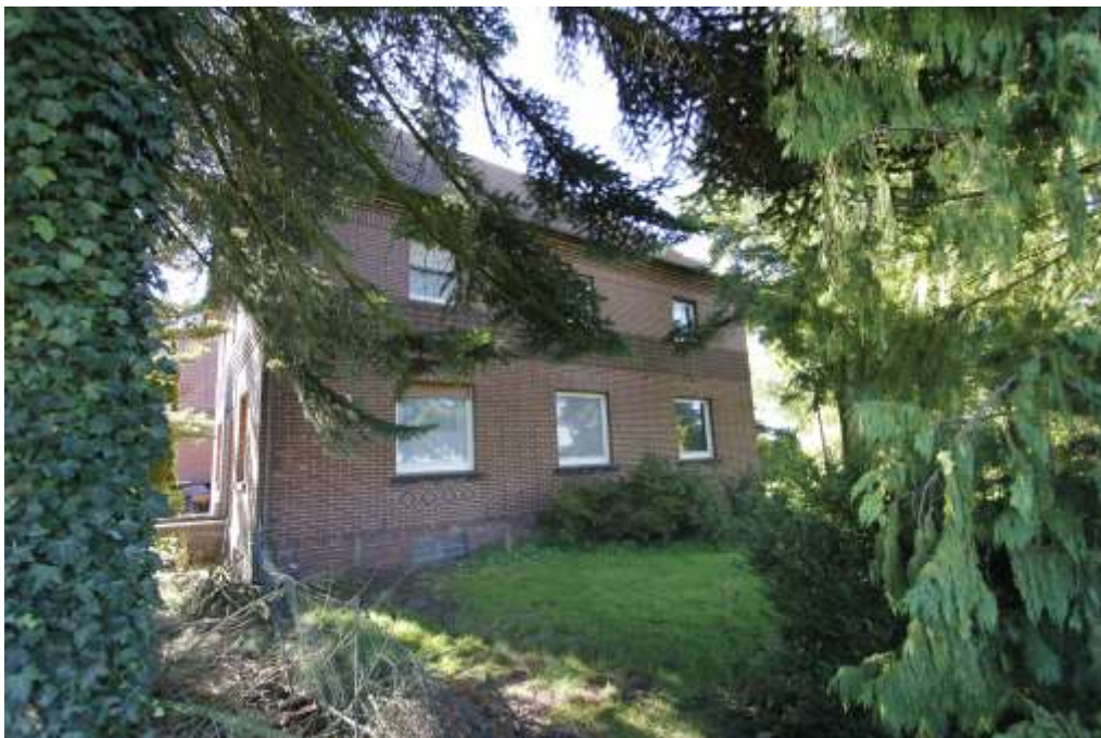
Ansicht Osten – Wohnhaus
