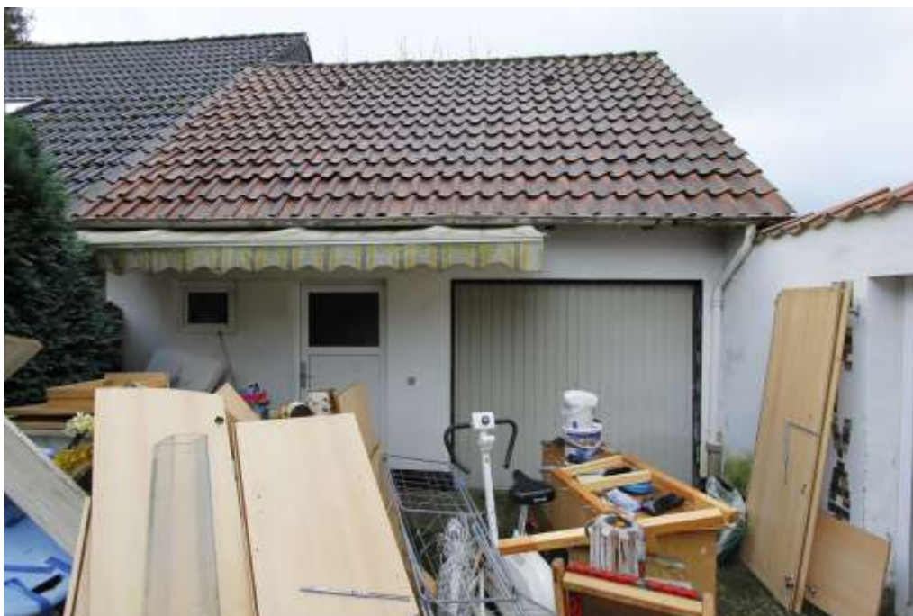
Ansicht Osten - Garage
