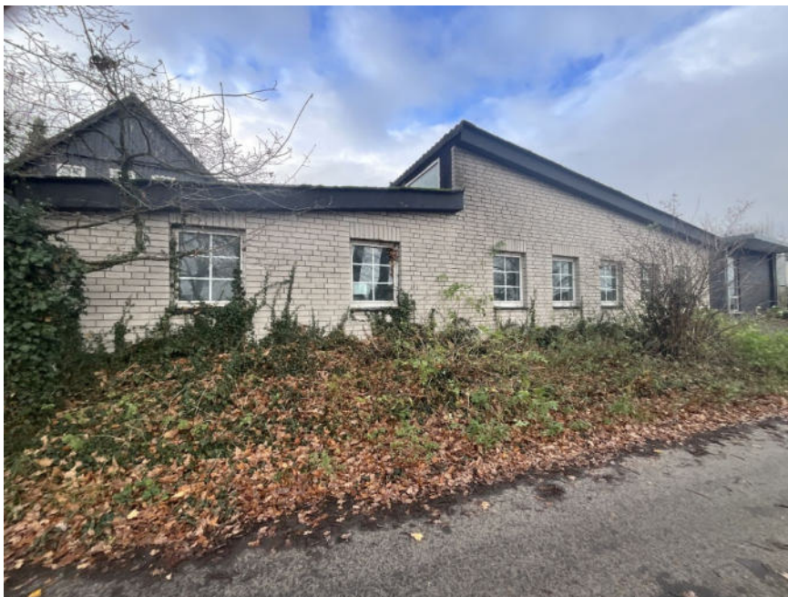
4) Werkstattgebäude mit Garage Südansicht
