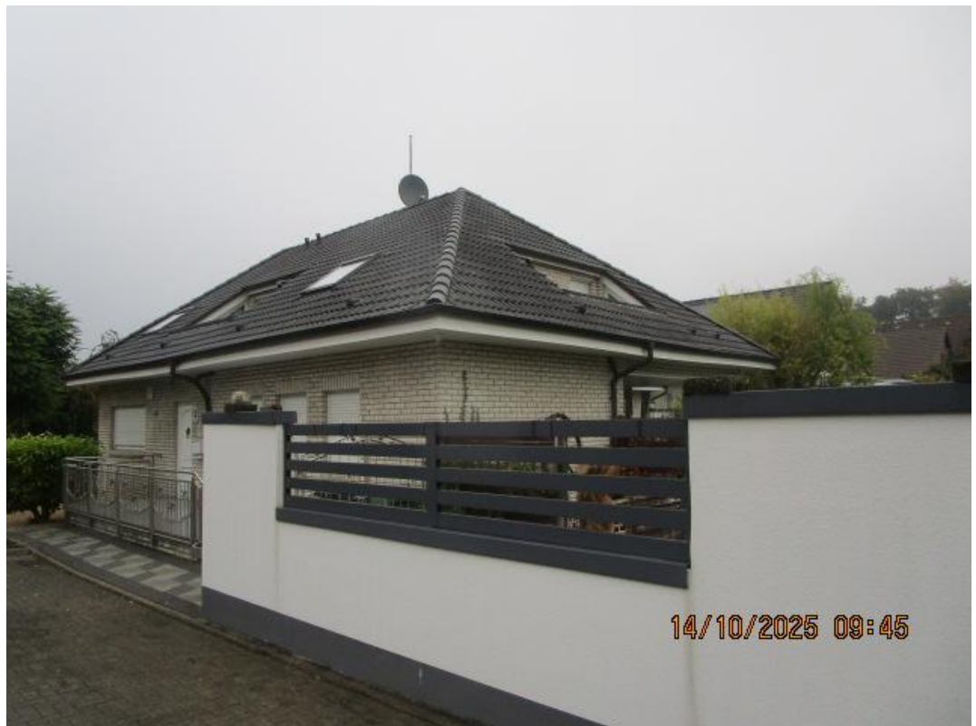
5) (I) Wohnhaus Südansicht
