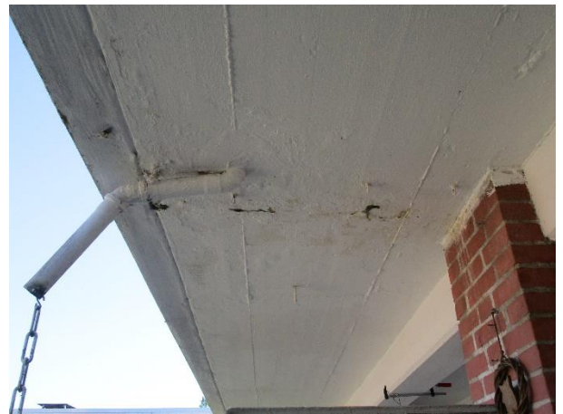
Feuchtigkeitsschaden Balkon
