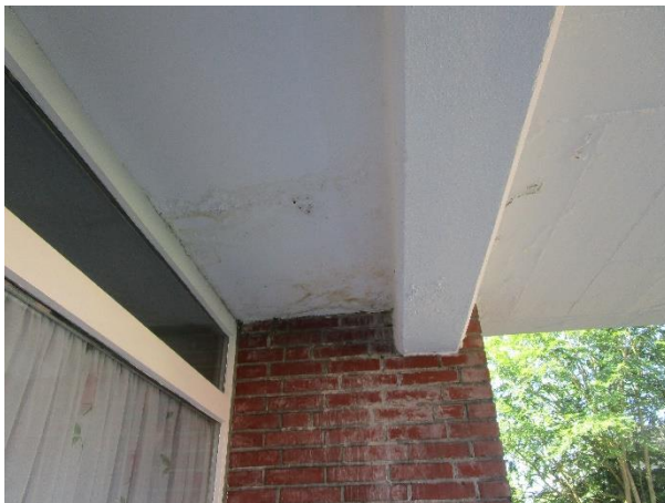
Feuchtigkeitsschaden Balkon
