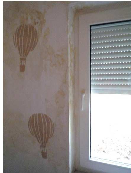
Feuchtigkeit Außenmauerwerk
