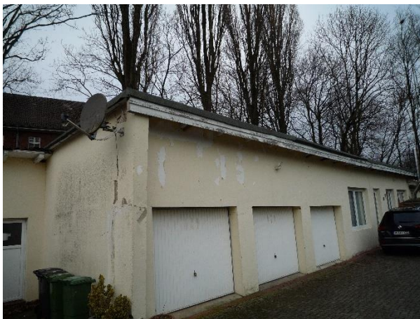
Außenansicht ehem. Werkhalle
