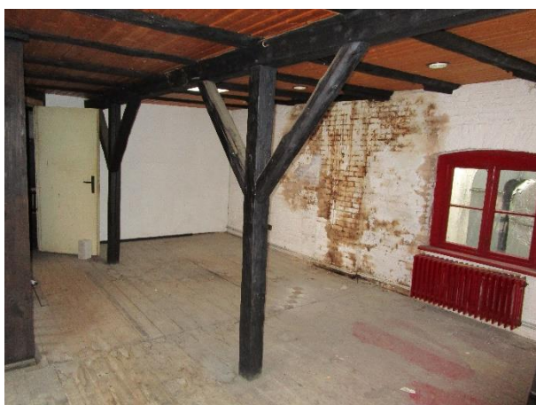
Dachboden/Feuchtschäden
