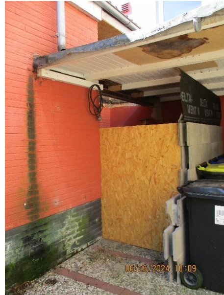
Anbau rechte Haushälfte
