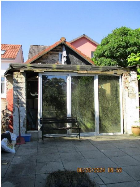
Anbau rechte Haushälfte
