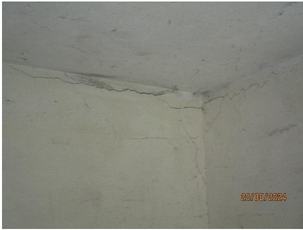
Risse im Mauerwerk
