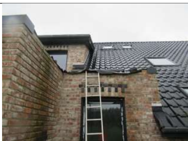
Dach Anschlussraum nicht fertiggestellt
