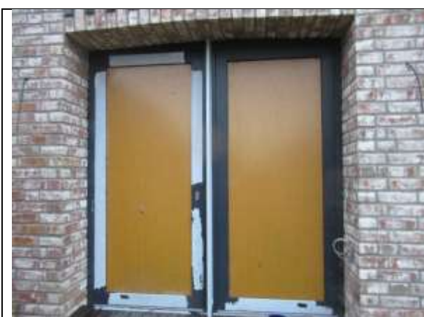
Außentüren mit Baustellenfüllung, Schutzfolie nicht entfernt
