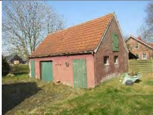
Ansicht Nebengebäude von Südosten
