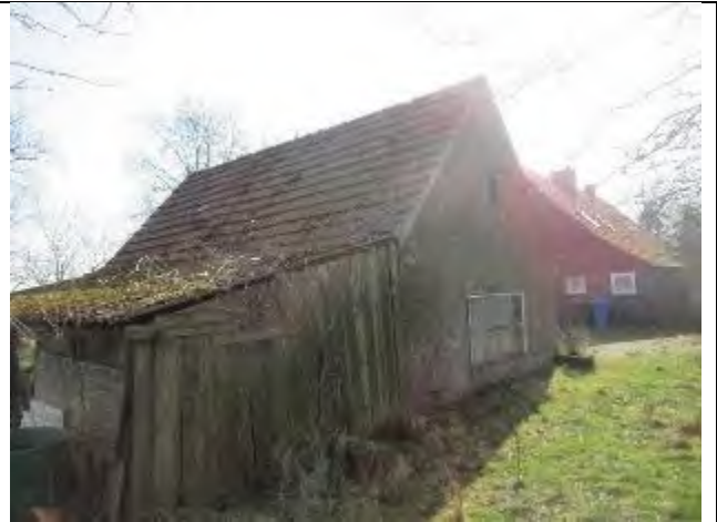
Ansicht Nebengebäude von Nordwesten
