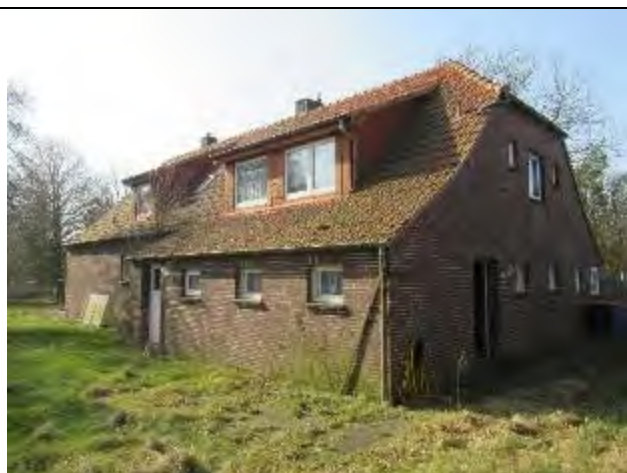
Ansicht Wohnhaus von Nordosten
