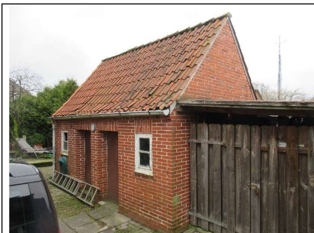
Ansicht Nebengebäude von Nordosten
