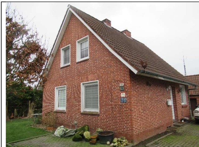
Ansicht Wohnhaus von Nordosten
