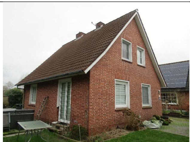
Ansicht Wohnhaus von Südosten
