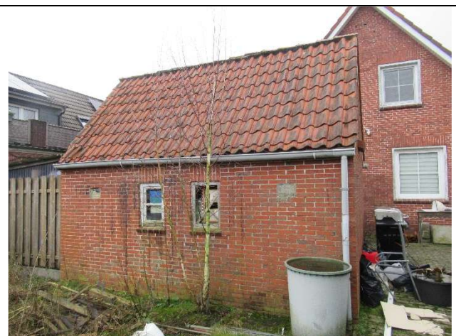
Ansicht Nebengebäude von Westen
