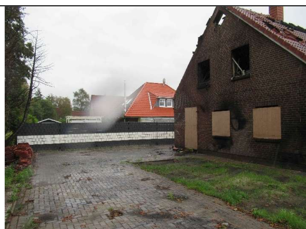
Gepflasterte Fläche im rückwärtigen Bereich
