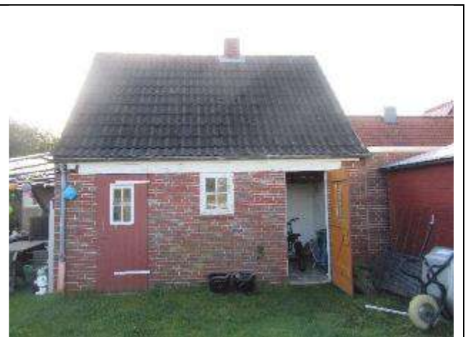
Ansicht Nebengebäude von Norden
