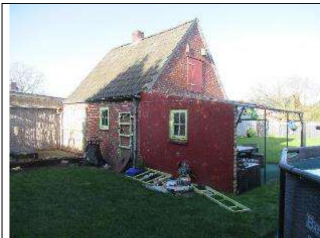
Ansicht Nebengebäude von Südosten
