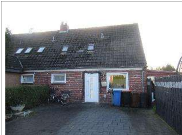
Ansicht Wohnhaus von Norden
