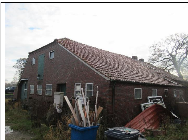
Ansicht Siedlungshaus von Nordwesten
