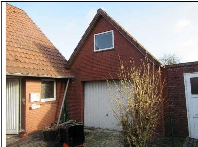
Ansicht Garage von Westen
