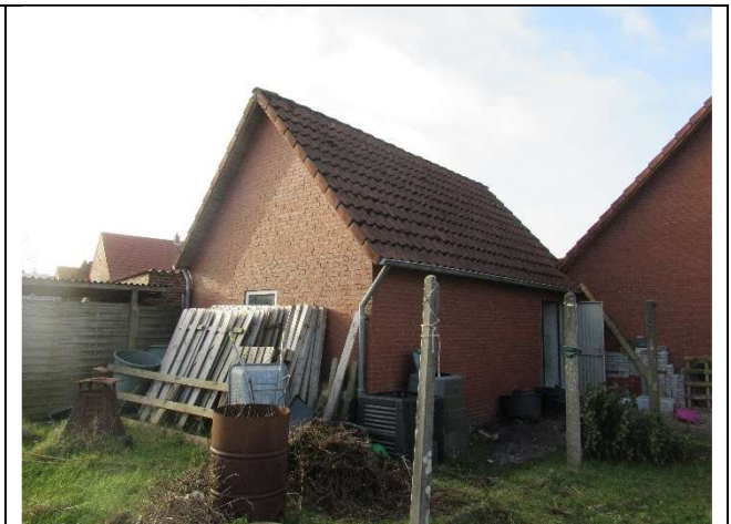
Ansicht Garage von Nordwesten
