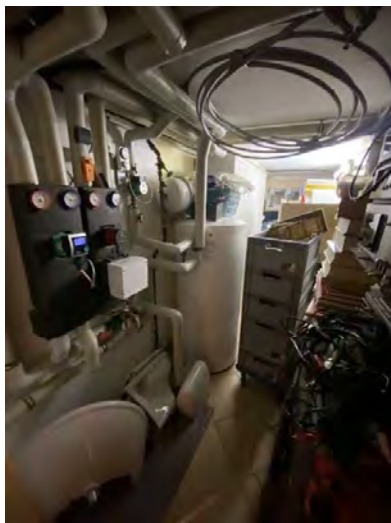
Warmwasserspeicher
