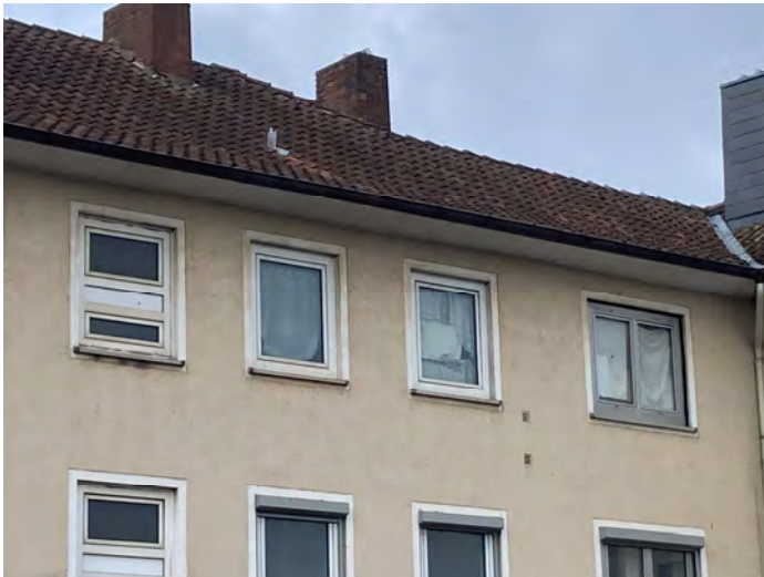
Straßenansicht Wohnung 2. OG
