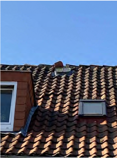
Beschädigte Dachpfannen
